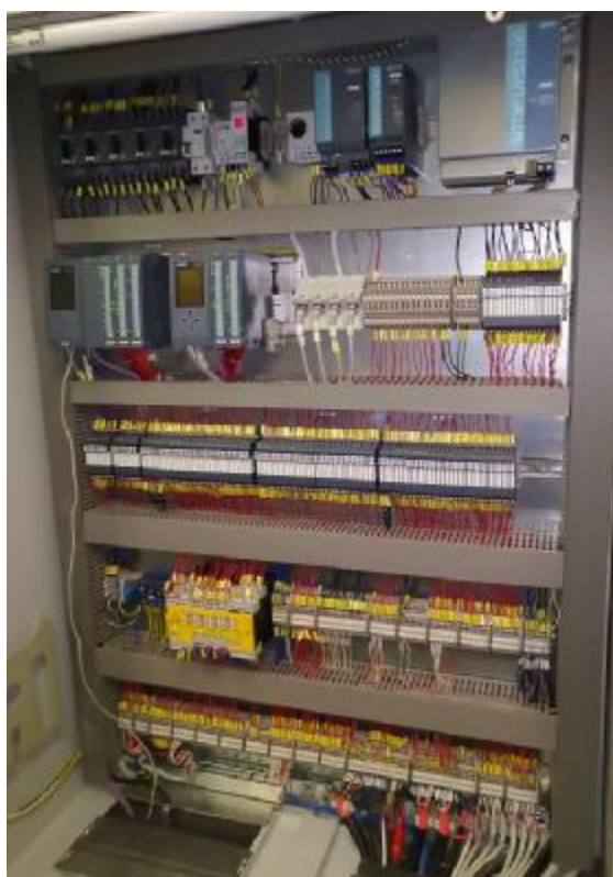
Рисунок 2 - Общий вид шкафа контроллера ШК1
