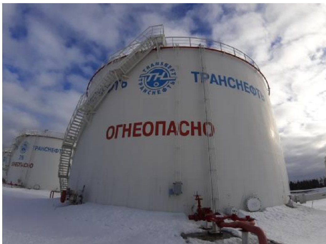
Рисунок 1 – Общий вид резервуаров РВС-5000 зав.№№ 27, 28, 29
