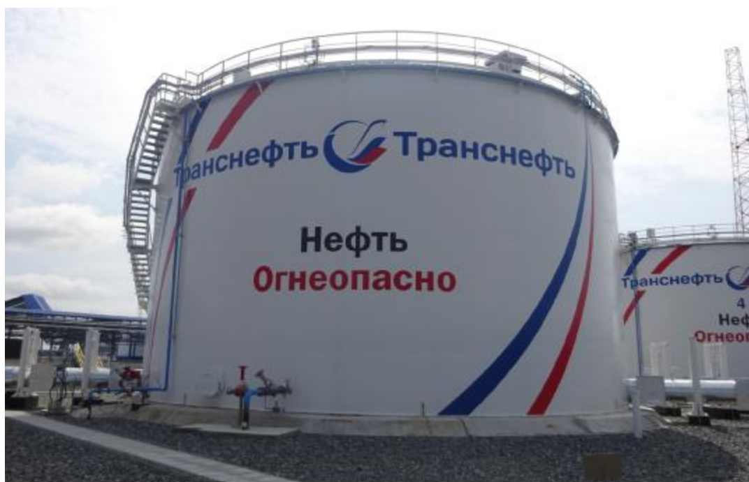
Рисунок 1 – Общий вид резервуаров РВС-5000 зав.№№ 3, 4
