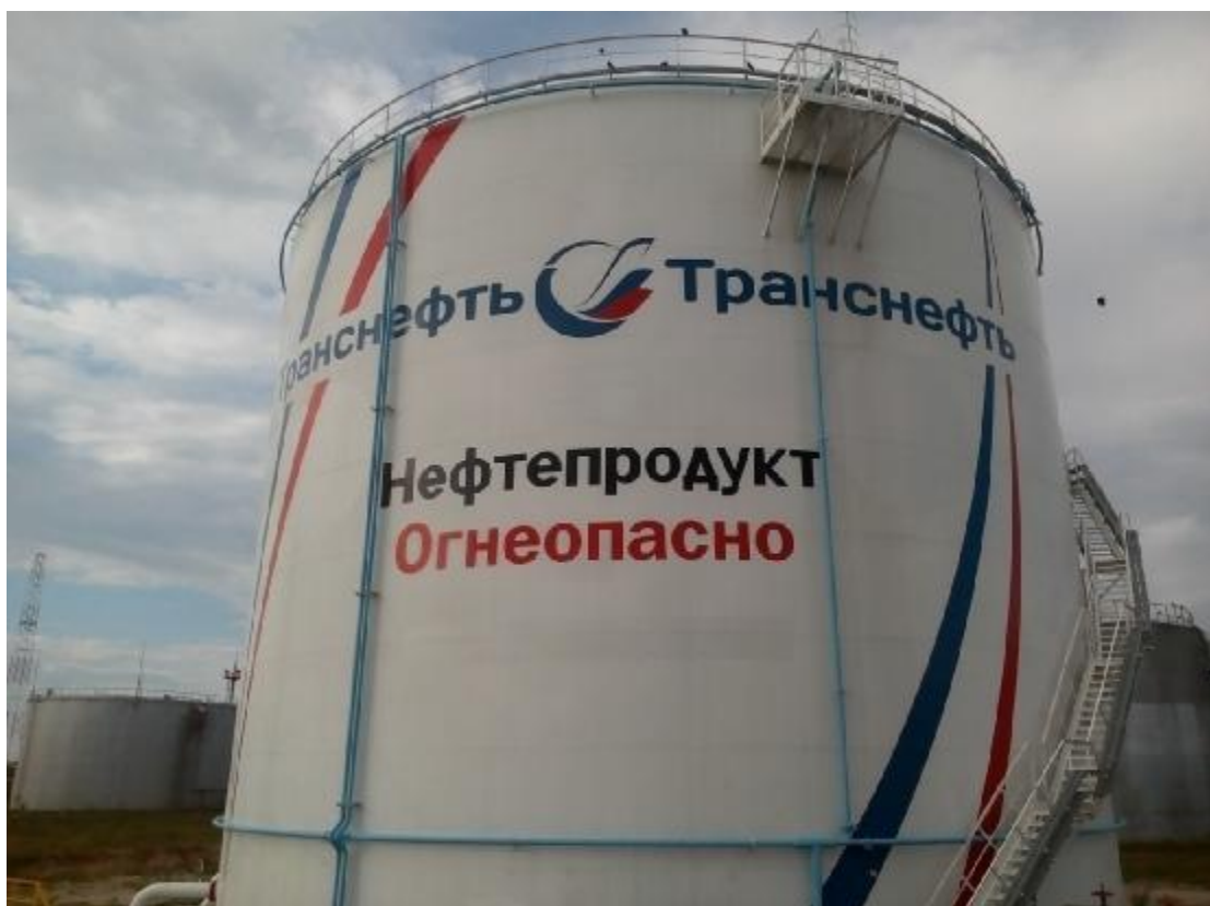
Рисунок 2 – Общий вид резервуаров РВС-7500 зав.№№ 10, 19
