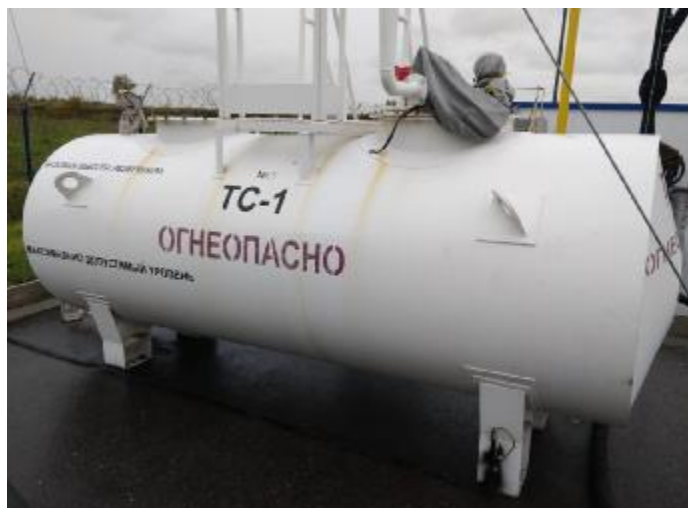
Рисунок 1 – Общий вид резервуара стального горизонтального цилиндрического РГС-5
