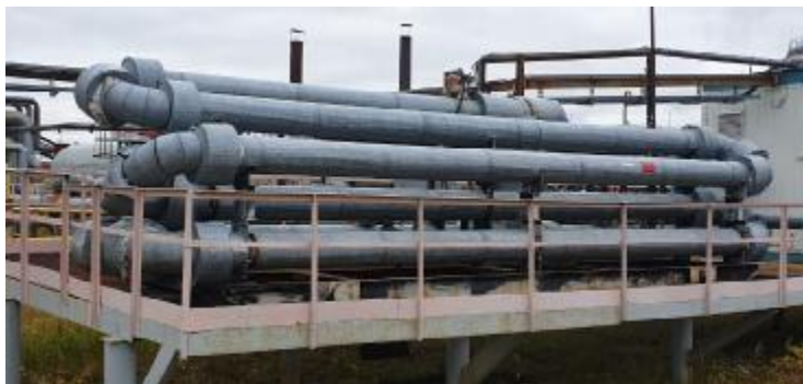
Рисунок 2 – Общий вид установки трубопоршневой поверочной стационарной «Прувер С-280-6,3», заводской № 34
