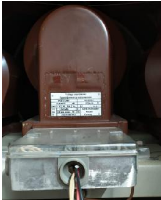
Рисунок 1 – Общий вид трансформаторов напряжения UGE, UGE 17,5B3
