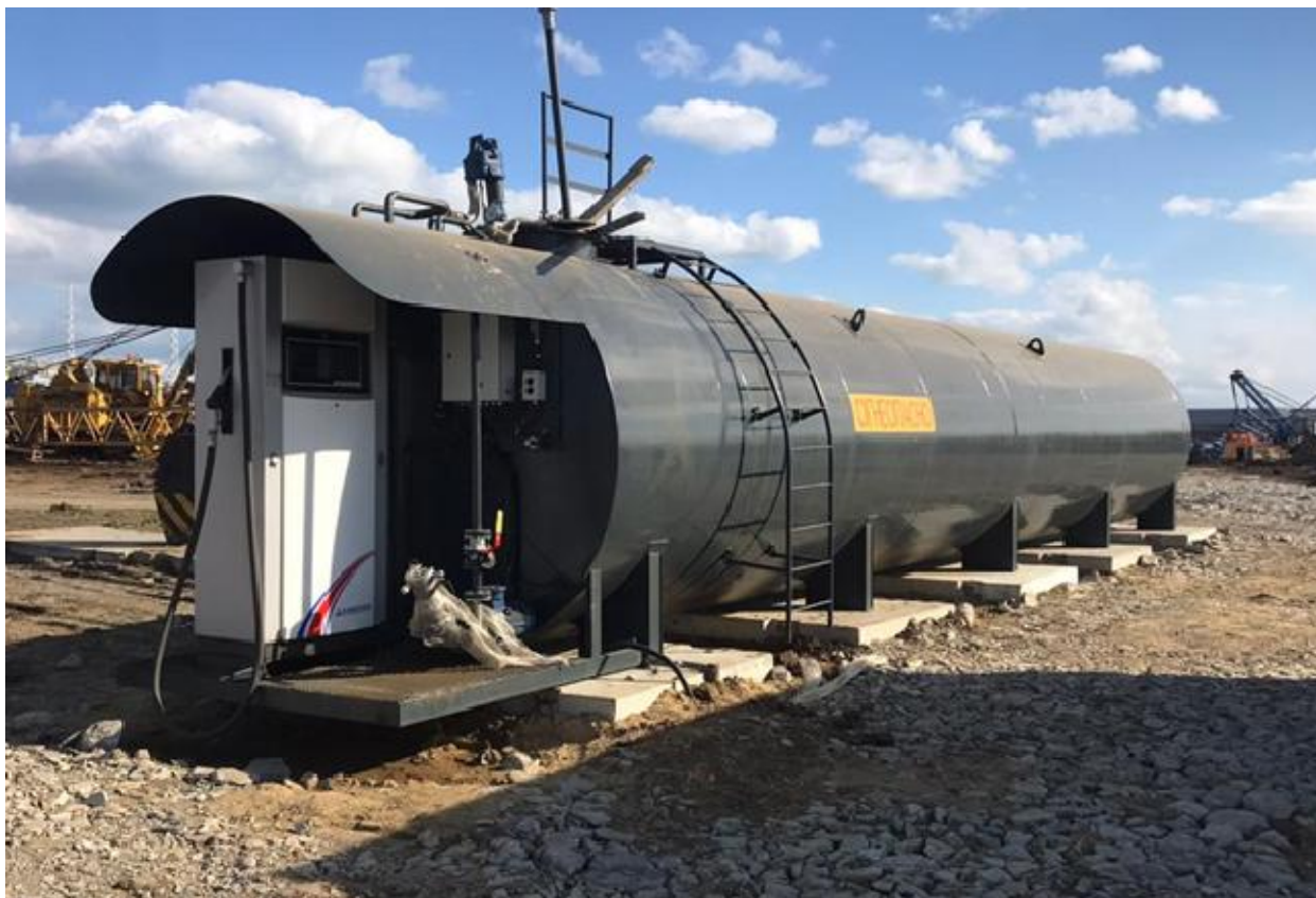
Рисунок 1 – Общий вид резервуаров
