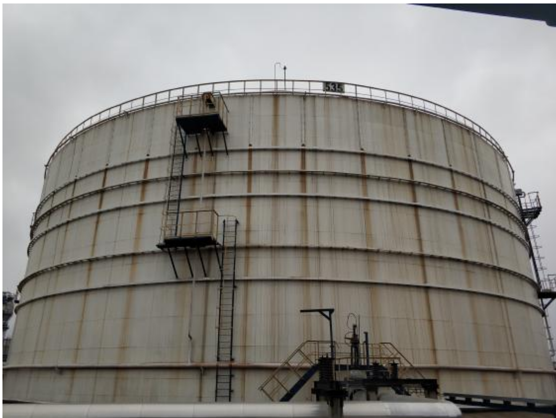
Рисунок 1 – Общий вид резервуара РВС-30000
