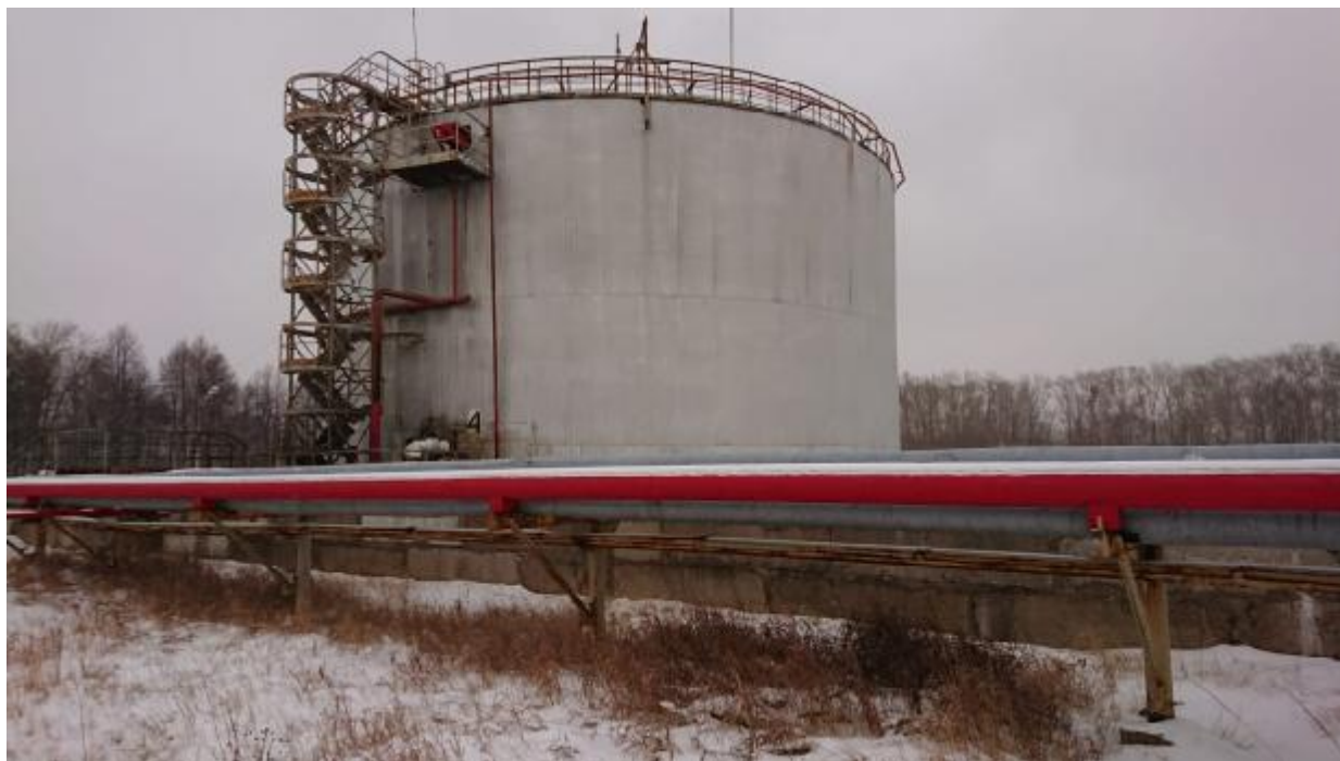
Рисунок 1 – Общий вид резервуара стального вертикального цилиндрического РВС-5000 № 4
