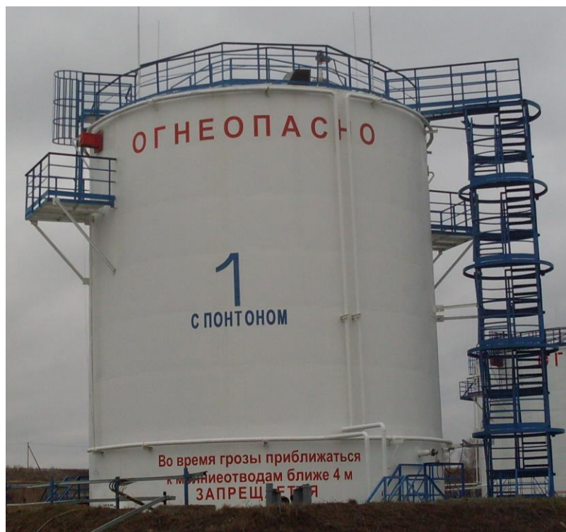
Рисунок 1 – Общий вид резервуаров стальных вертикальных цилиндрических РВСП-1000 и РВС-1000
