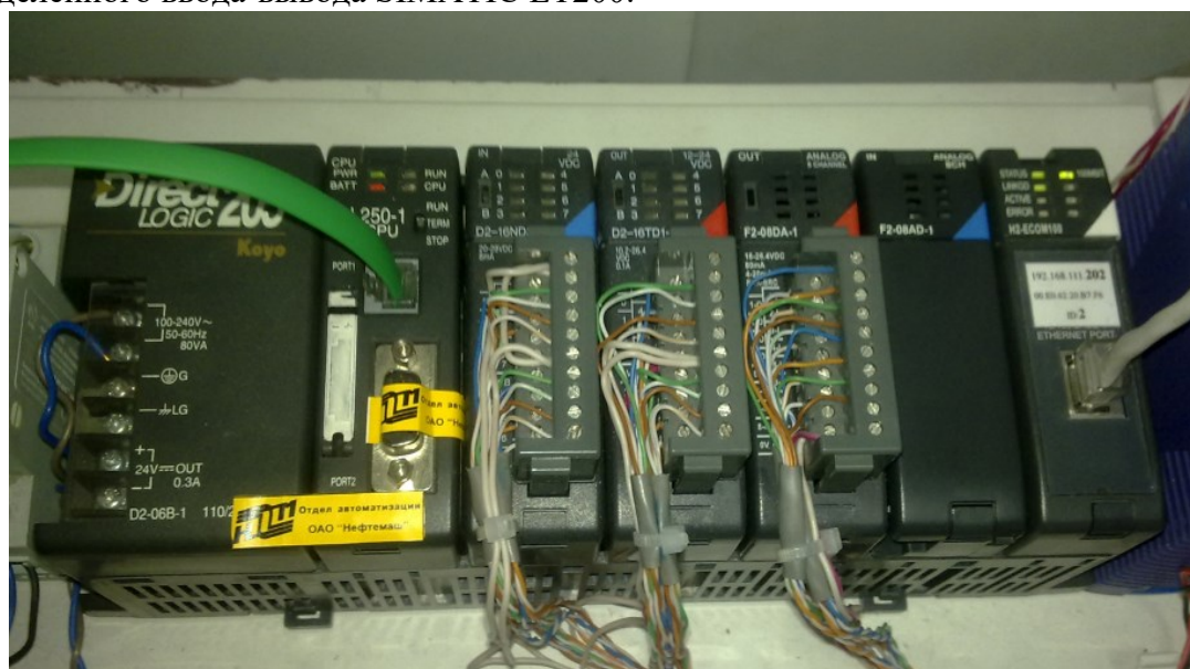
Рисунок 4 – Место пломбировки от несанкционированного доступа контроллера программируемого DirectLOGIC
