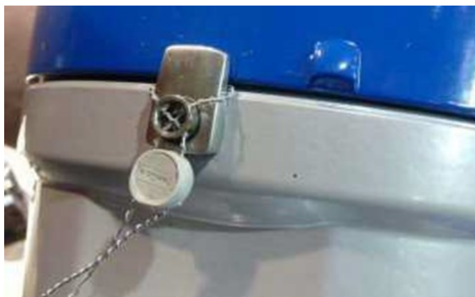
Рисунок 3 – Защита преобразователей сигналов IFC 300 F/PF и клеммной коробки первичных преобразователей TIDALFLUX 2000 от вскрытия
