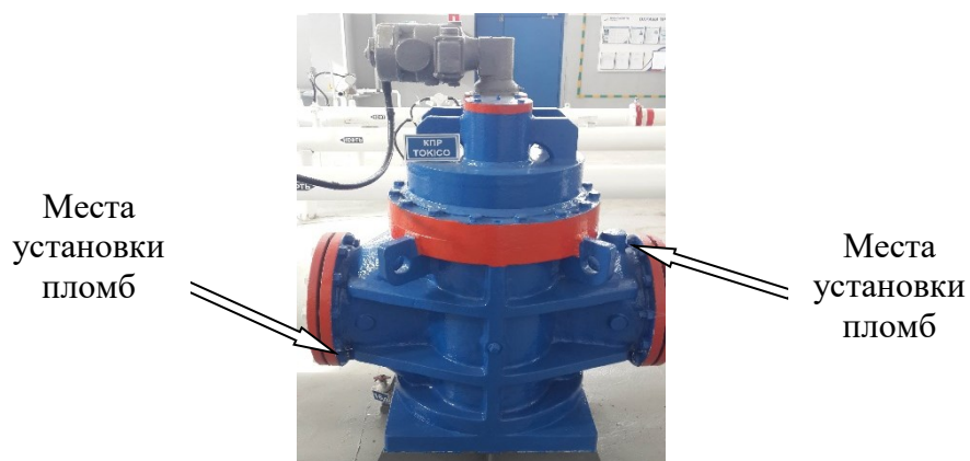
Рисунок 1 – Схема пломбировки от несанкционированного доступа ПР.*
