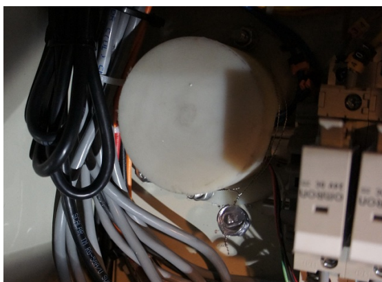
Рисунок 12 – Пломбирование преобразователей температуры PR, ПСТ, ИП 0304/М3-Н
