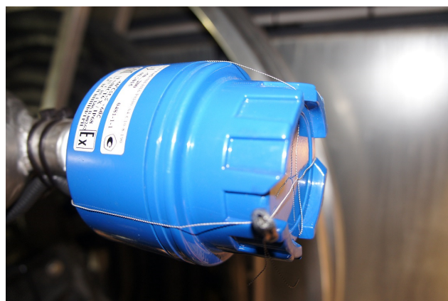
Рисунок 13 – Пломбирование датчика температуры
