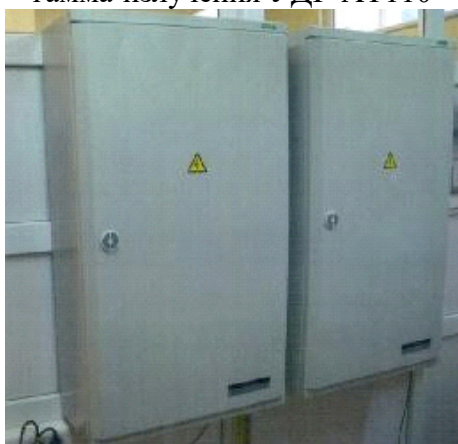
Рис. 3 Блок управления ДУО-АТ110 и блок управления КС-АТ110
