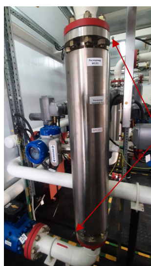
Рисунок 2 – Места нанесения заводского номера, знака утверждения типа, знака поверки и места установки пломб
