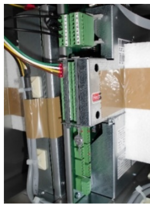
Рисунок 6 - Место пломбирования блока питания ER5
