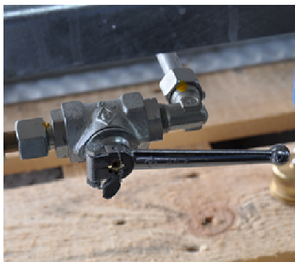
Рисунок 9 - Места пломбирования обводной линии
