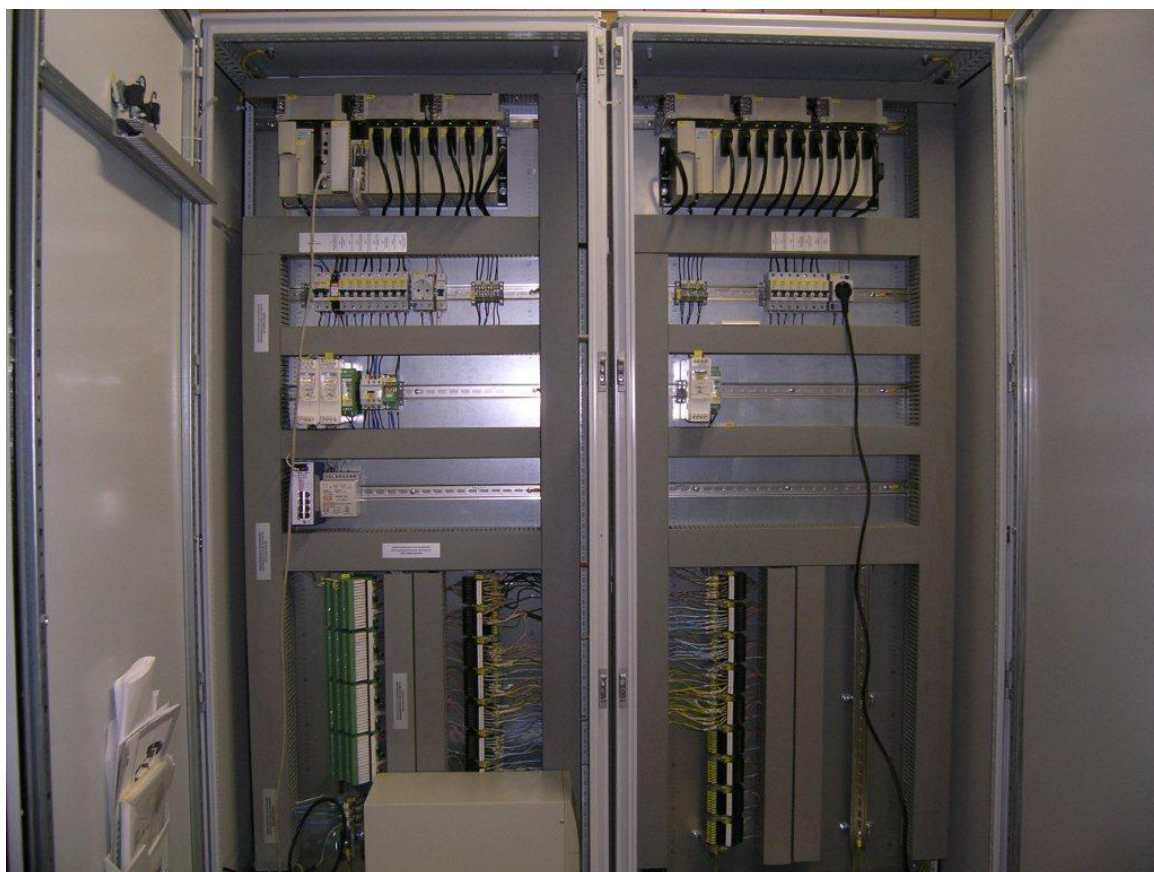
Рисунок 1 - Фотография шкафов с контроллерами и модулями ввода
