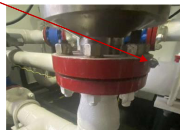
Рисунок 2 – Места нанесения заводского номера, знака утверждения типа, знака поверки и места установки пломб
