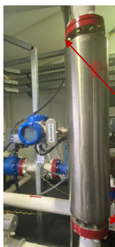
Рисунок 2 – Места нанесения заводского номера, знака утверждения типа, знака поверки и места установки пломб
