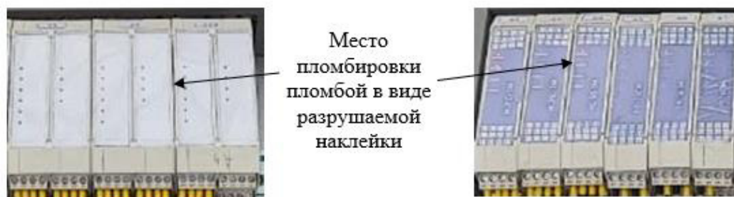
Рисунок 4 - Схема пломбировки от несанкционированного доступа пломбой в виде разрушаемой наклейки
