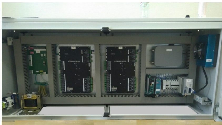
Рисунок 1—Общий вид системного блока аппаратуры вибродиагностики и мониторинга машинного оборудования Intellinova Parallel EN
