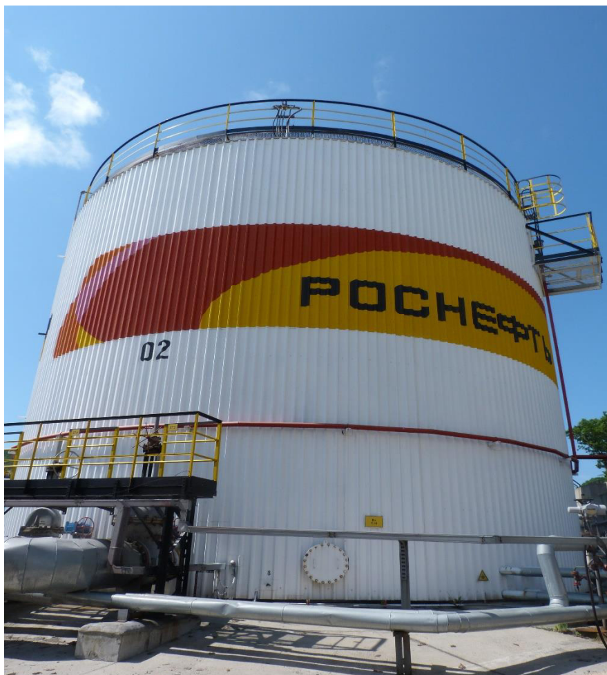
Рисунок 1 – Общий вид резервуара вертикального стального цилиндрического РВС-2000
