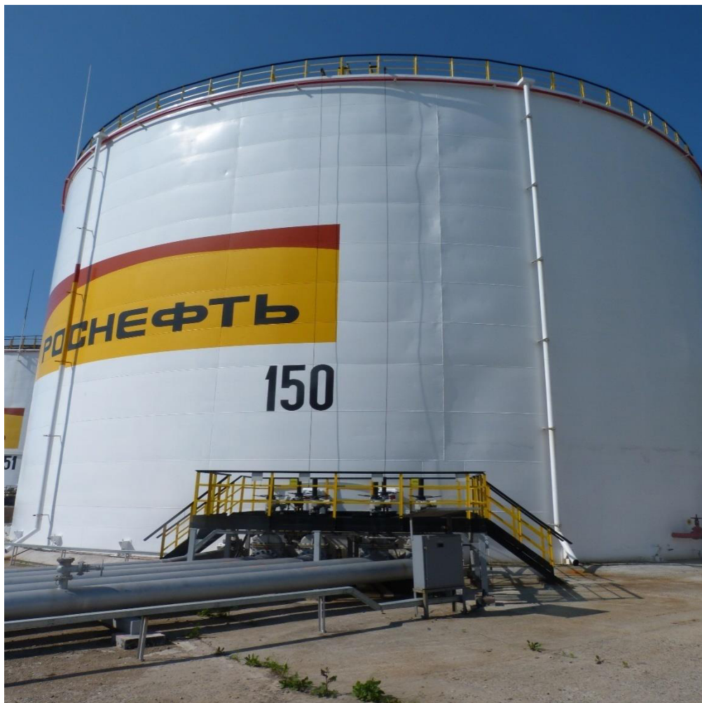
Рисунок 1 – Общий вид резервуара вертикального стального цилиндрического РВС-10000
