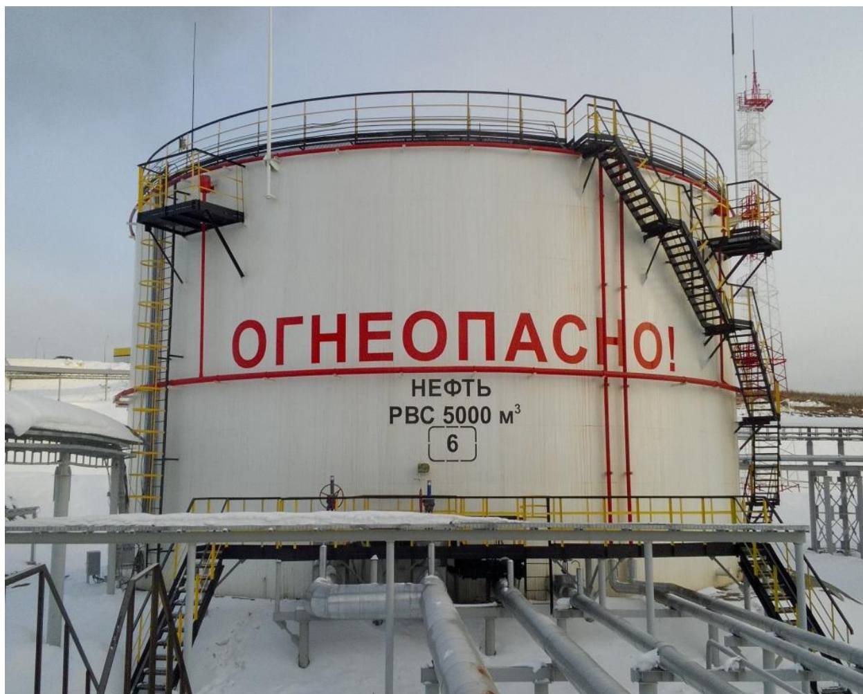
Рисунок 1 - Общий вид резервуара стального вертикального цилиндрического РВС-5000
