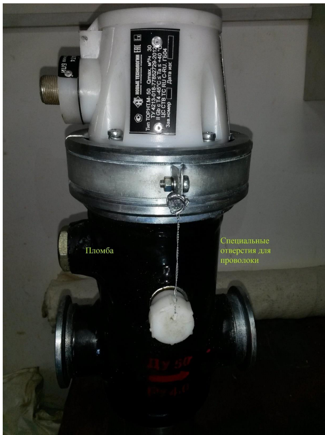
Рисунок 3 – Схема пломбирования счетчиков
