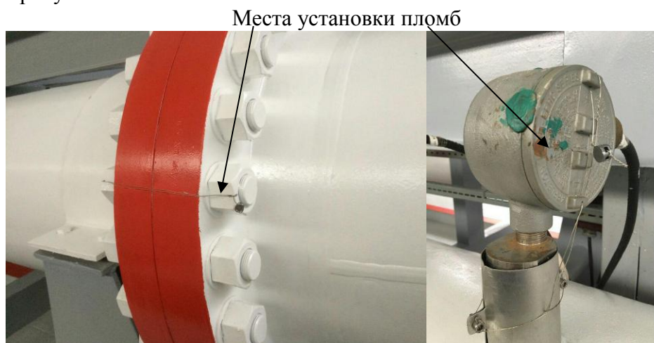
Рисунок 1 – Схема пломбировки от несанкционированного доступа, обозначение места нанесения знака поверки
