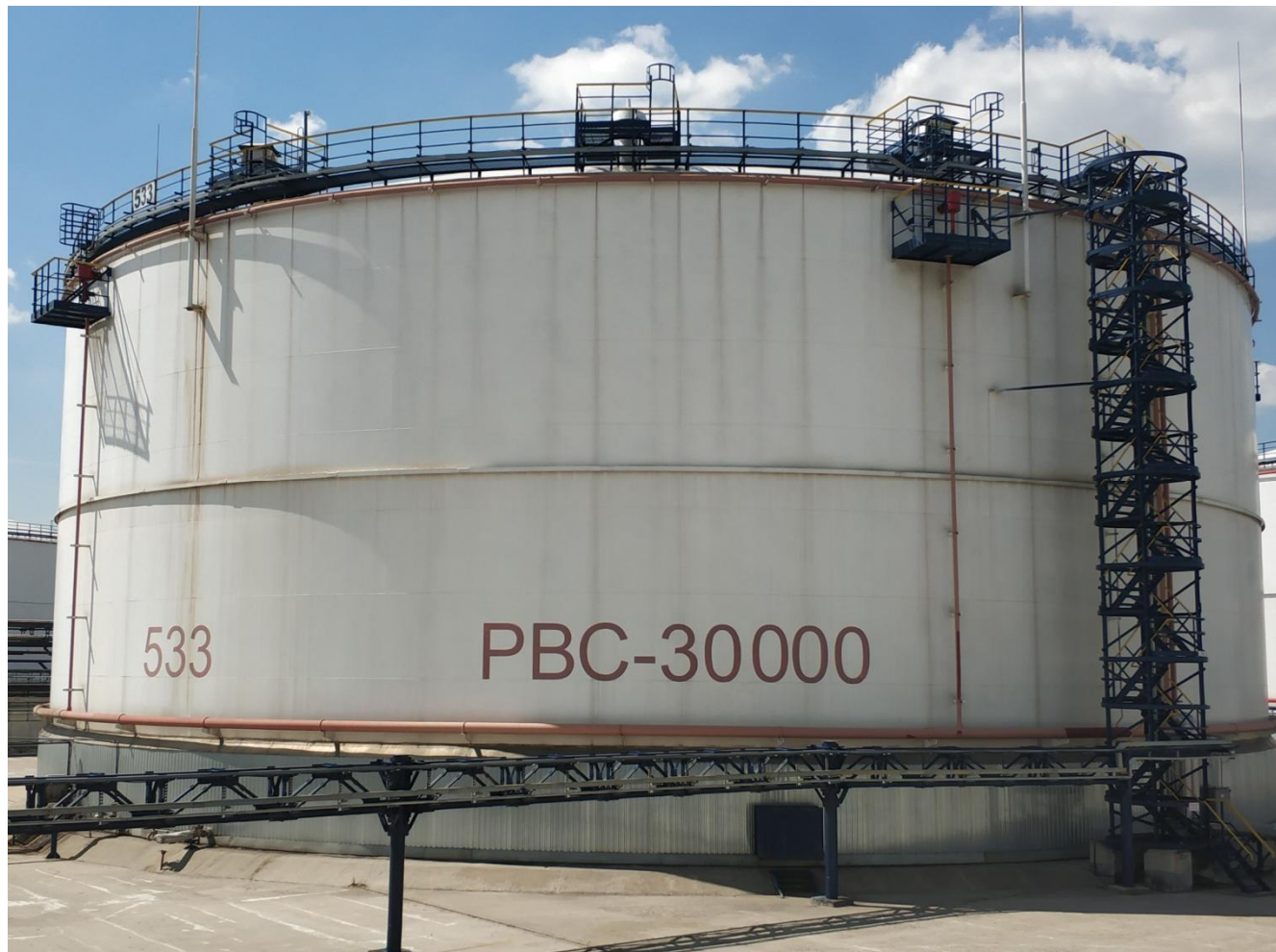
Рисунок 1 - Общий вид резервуара РВС-30000
