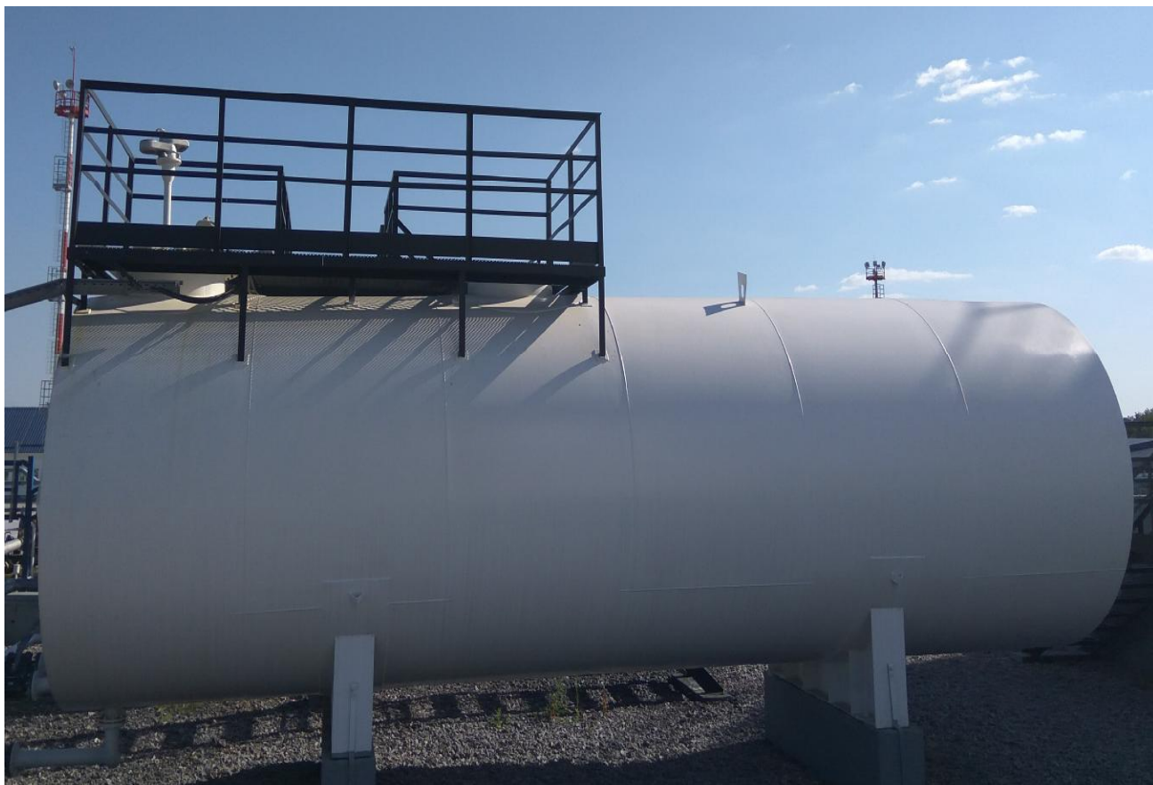
Рисунок 1 - Общий вид резервуара стального горизонтального цилиндрического РГС-50
