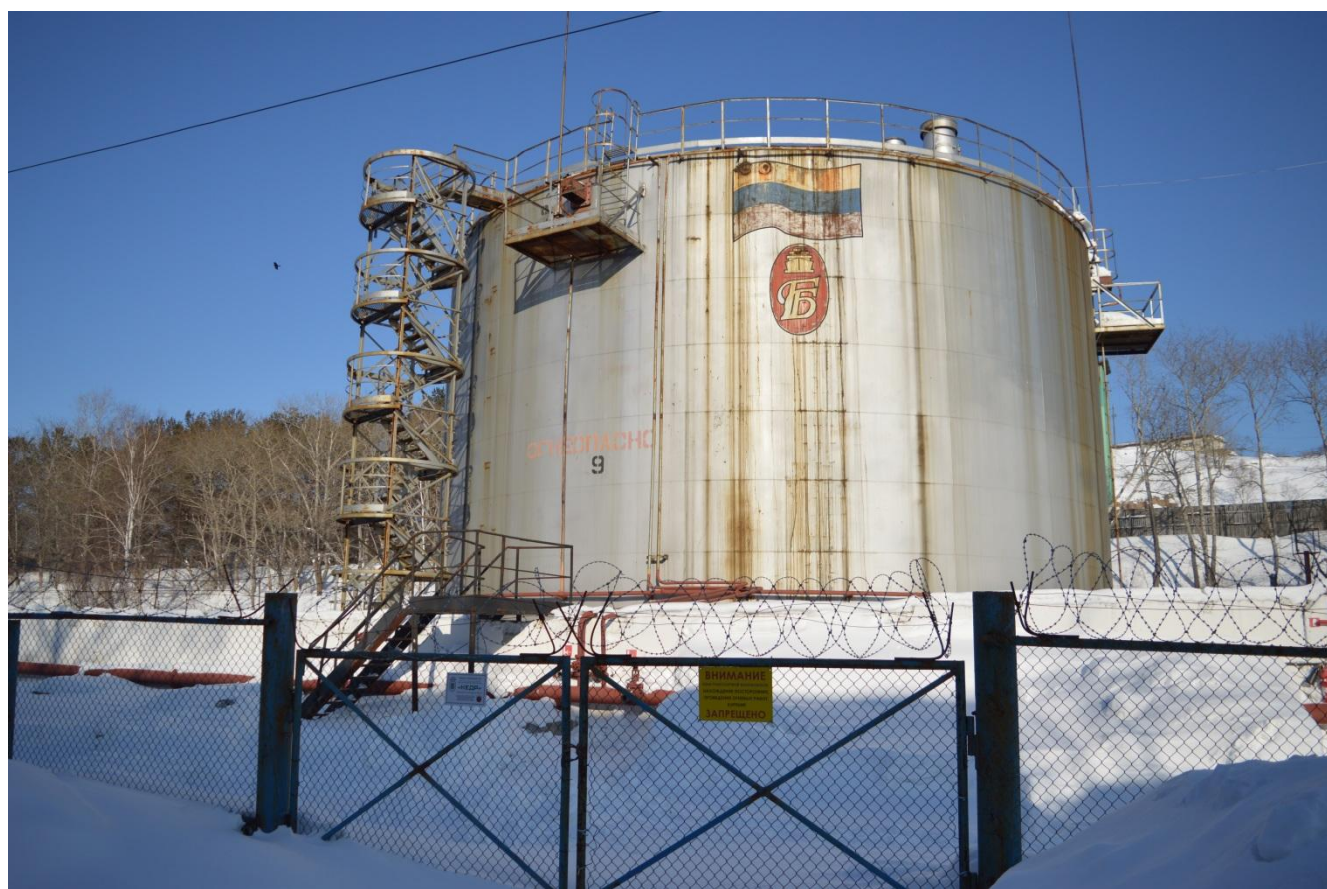
Рисунок 1 - Общий вид резервуара РВС-3000
