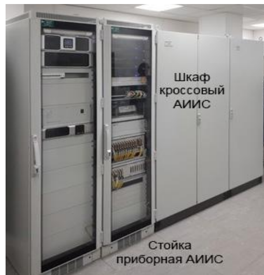
Рисунок 2 – Стойки и шкафы АИИС. Расположение
