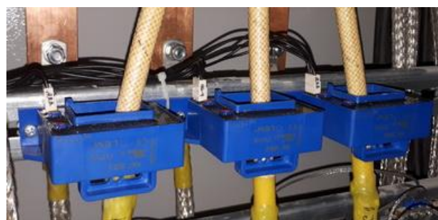
Рисунок 16 – Преобразователи тока первичные LEM HAT 200-S. Вид внешний
