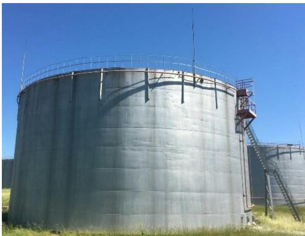
Рисунок 1 - Общий вид резервуаров
