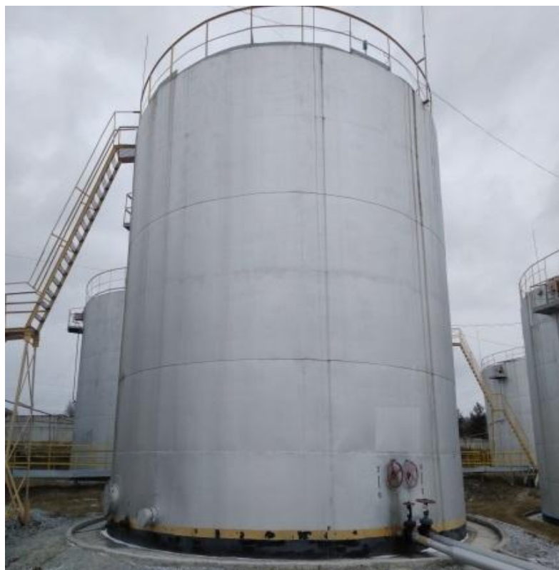
Рисунок 3 - Общий вид резервуара стального вертикального цилиндрического РВС-700
