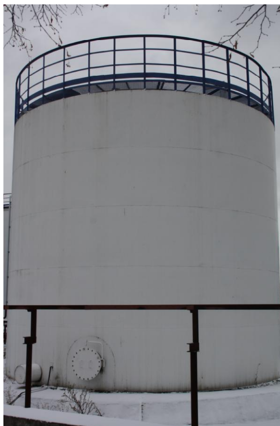
Рисунок 2 - Общий вид резервуара стального вертикального цилиндрического РВС-400
