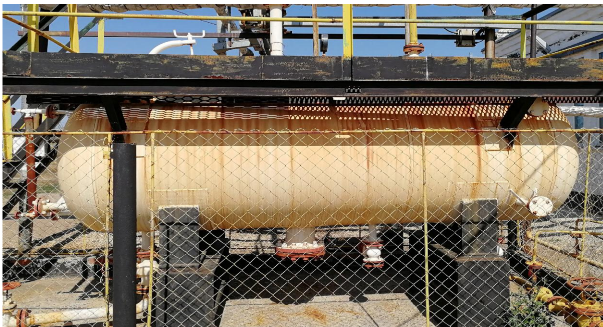
Рисунок 1 - Общий вид резервуара стального горизонтального цилиндрического РГС-5
