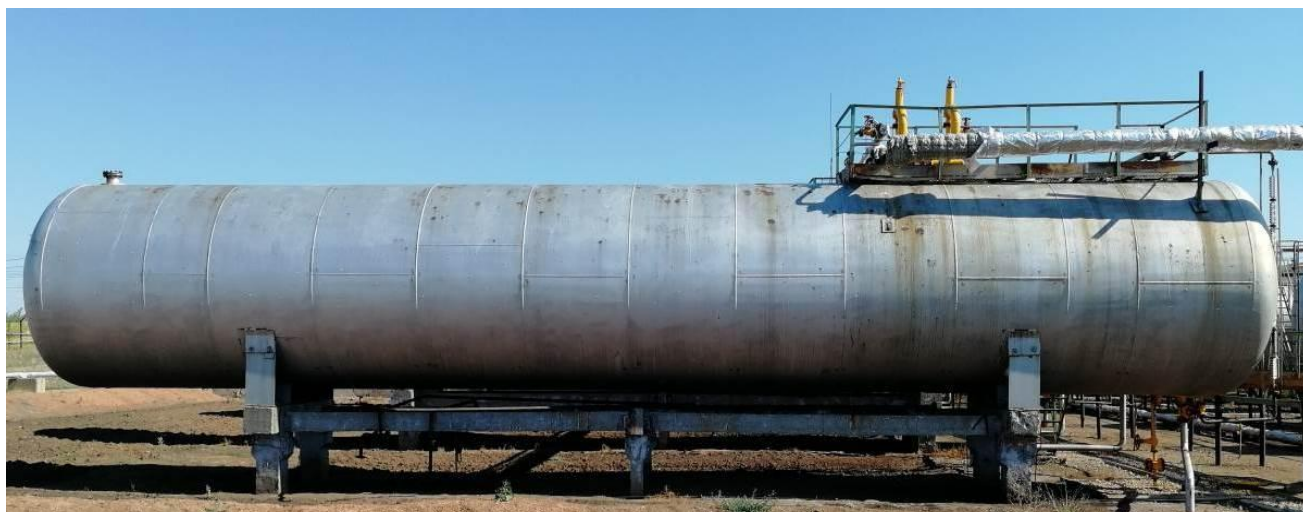
Рисунок 1 - Общий вид резервуара стального горизонтального цилиндрического РГС-200
