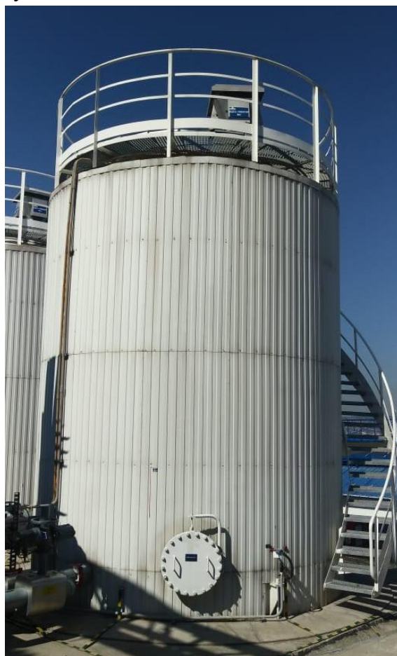
Рисунок 1 - Общий вид резервуара РВС-100
