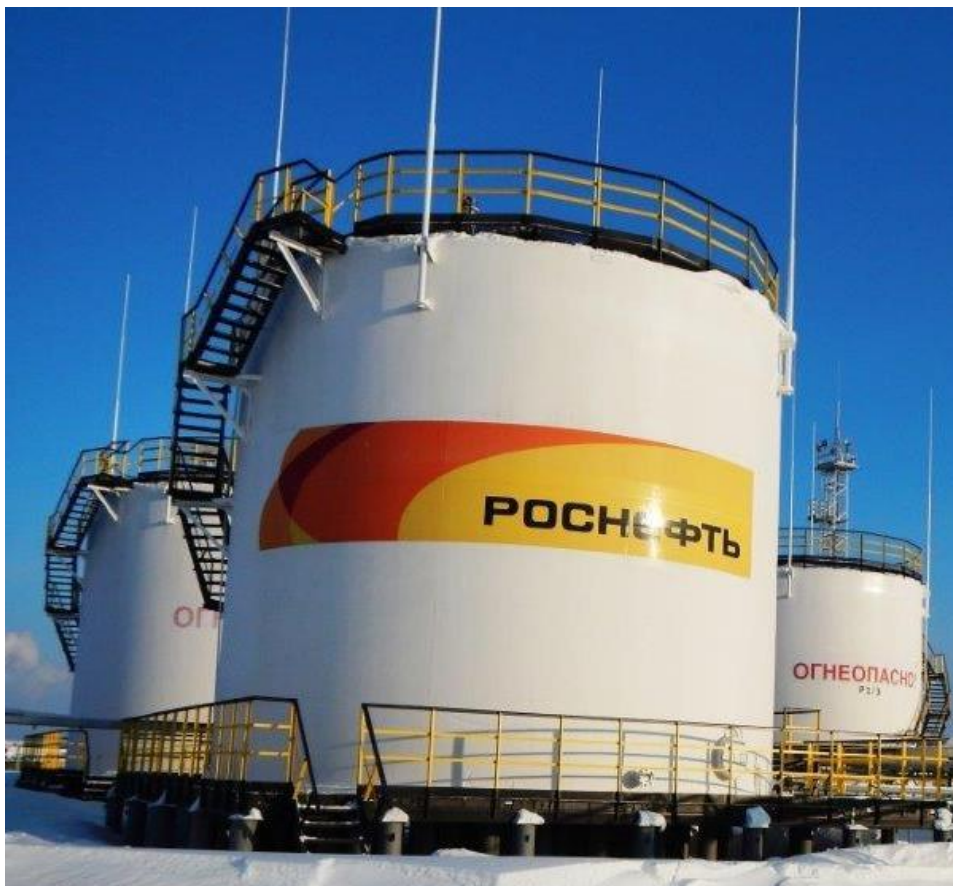
Рисунок 1 - Общий вид резервуара стального вертикального цилиндрического РВС-700
