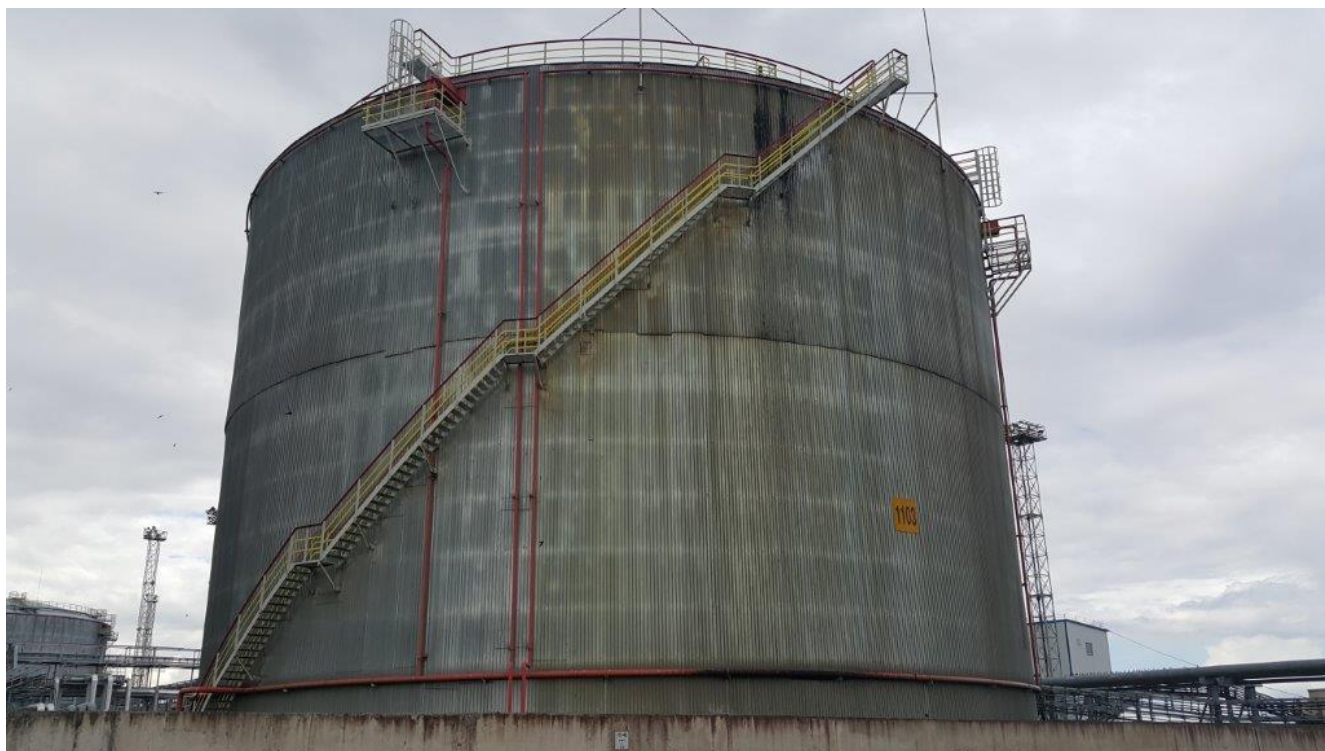
Рисунок 1 - Общий вид резервуара РВСт-15000
