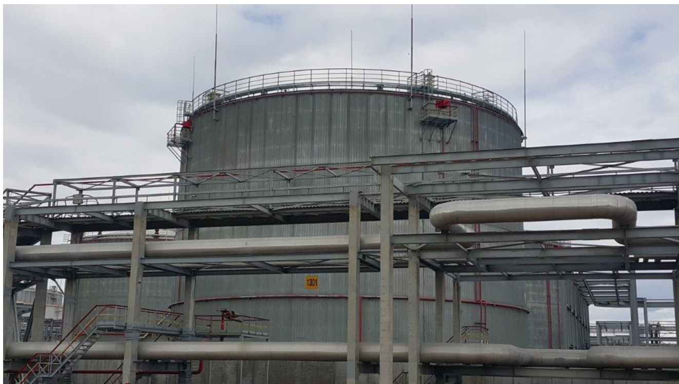
Рисунок 2 - Общий вид резервуара РВСт-20000
