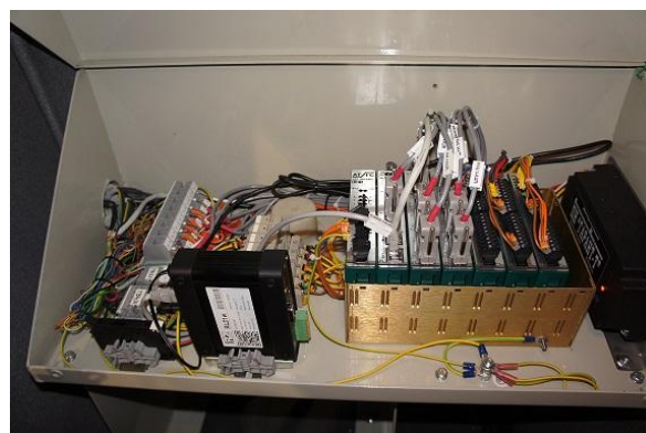
Рисунок 4 – БСК-01 без защитной крышки
