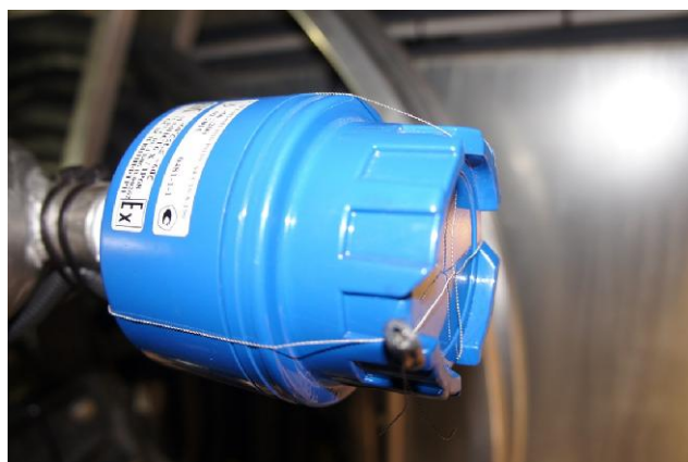
Рисунок 10 – Пломбирование датчика температуры
