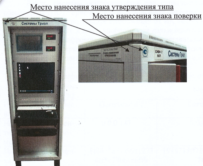
Рисунок 1 – Общий вид стойки управления
