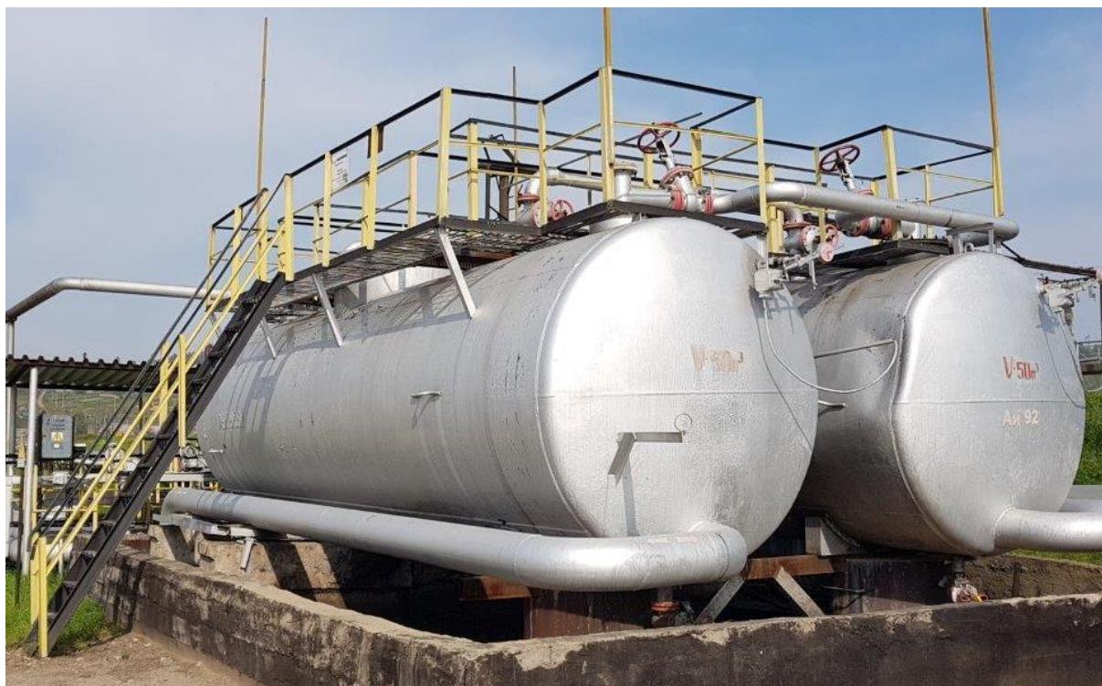
Рисунок 1 - Общий вид резервуара стального горизонтального цилиндрического РГС-50
