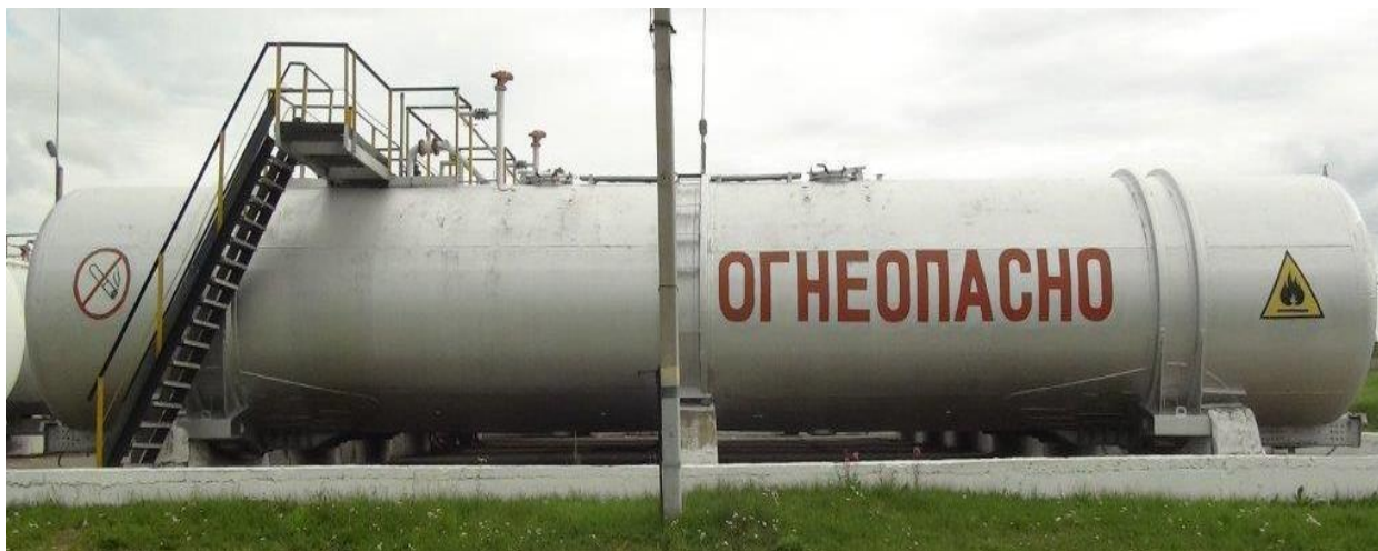
Рисунок 1 - Общий вид резервуара стального горизонтального цилиндрического РГС-137
