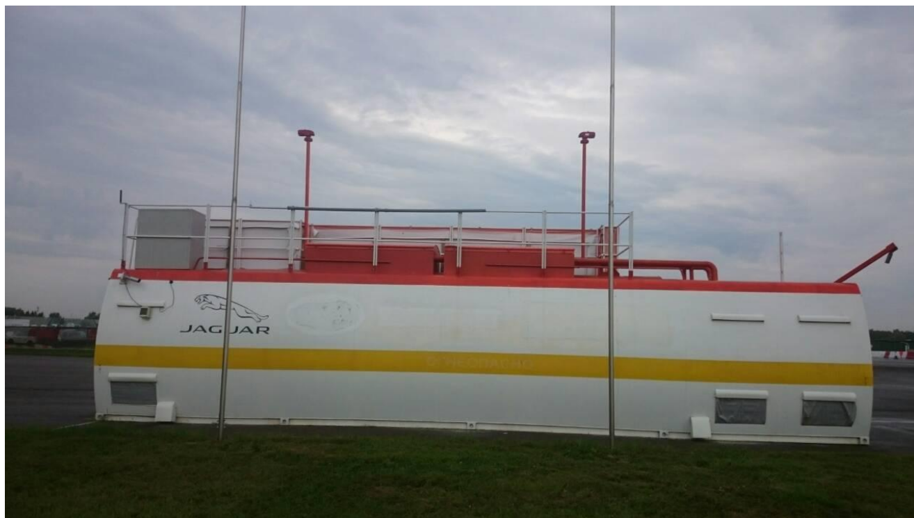
Рисунок 1 - Общий вид резервуара горизонтального стального цилиндрического двустенного РН2-25-12,5/12,5-2200
