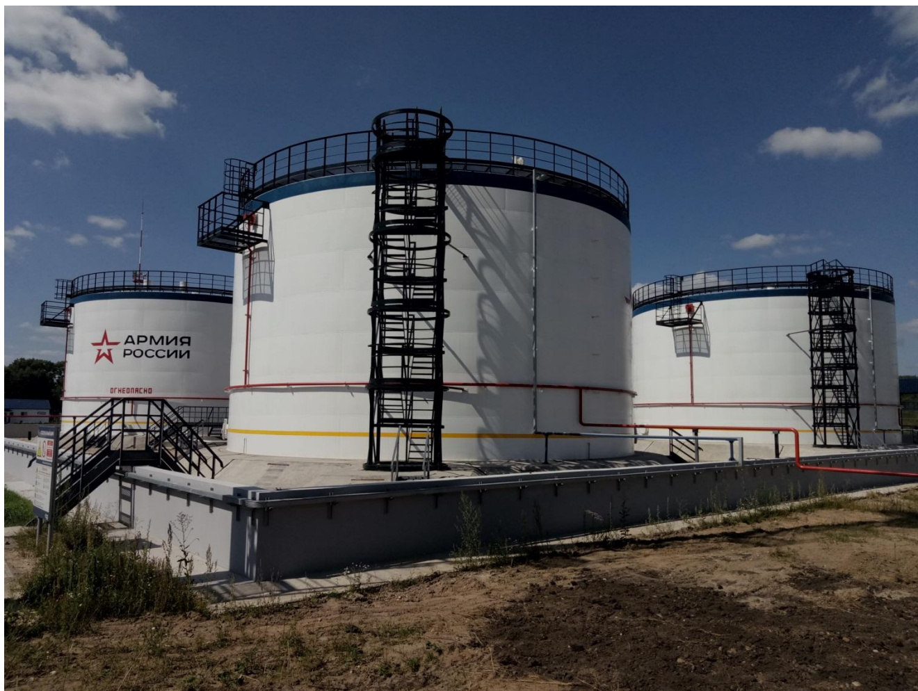
Рисунок 1 - Общий вид резервуаров РВС-2900
