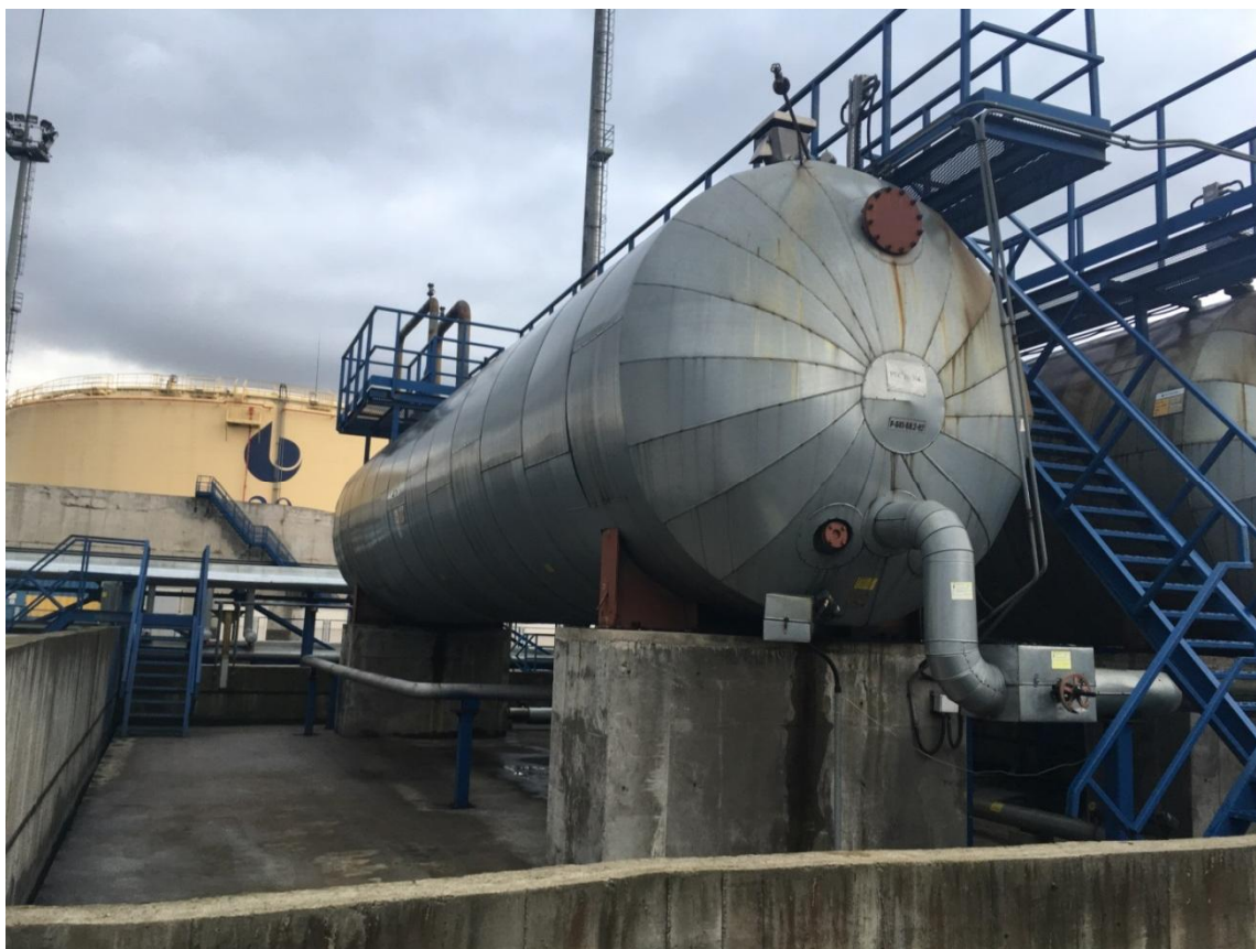
Рисунок 1 - Общий вид резервуара РГС-100
