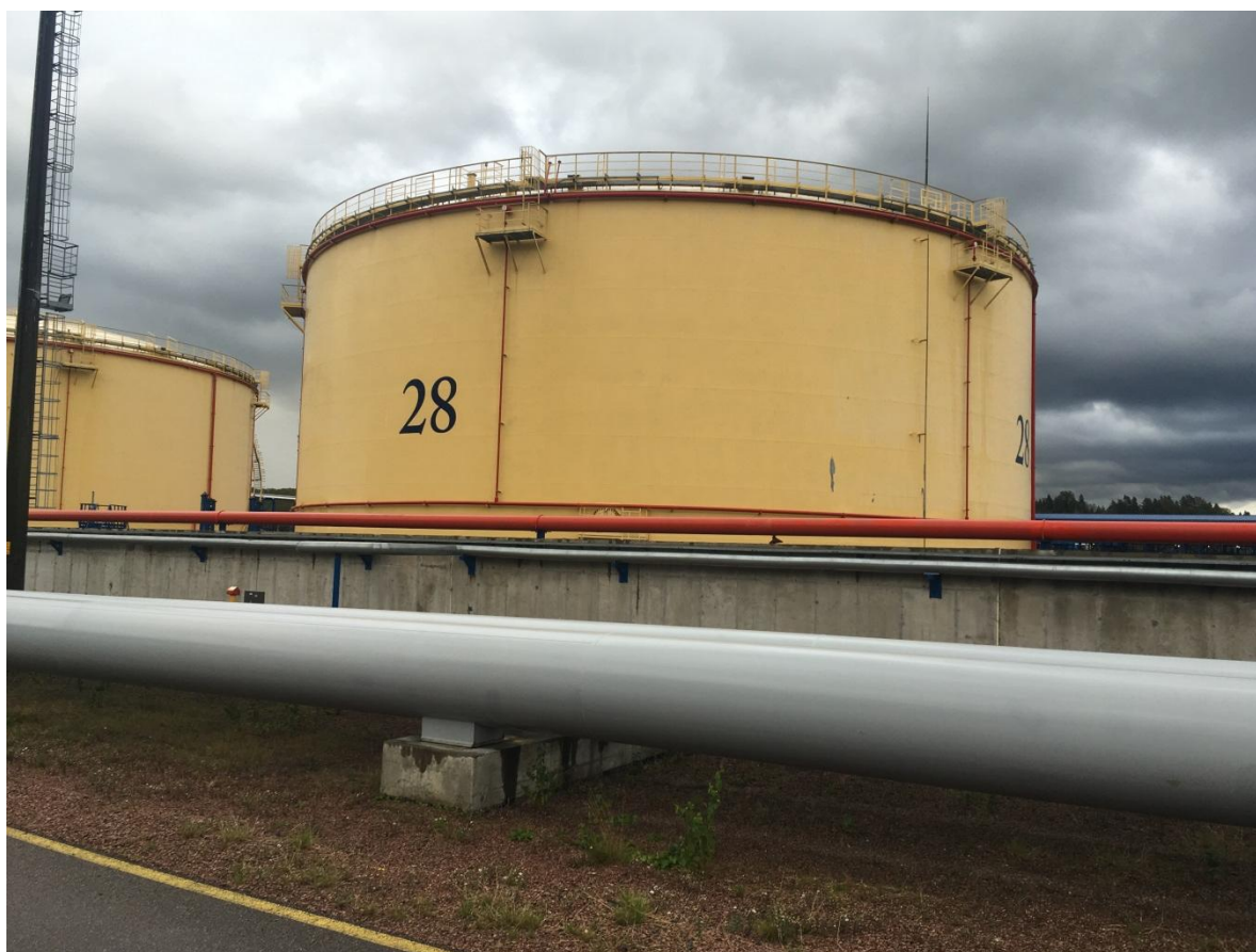
Рисунок 1 - Общий вид резервуара РВСП-30000
