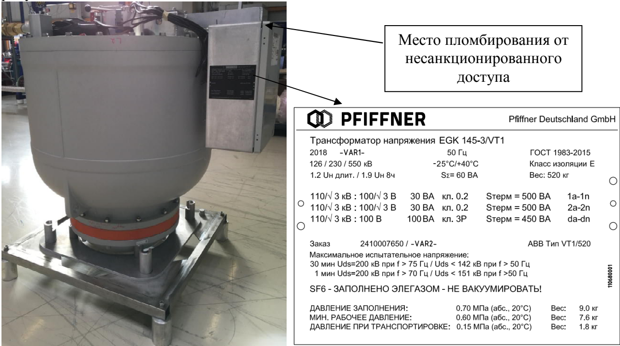
Рисунок 1 - Общий вид трансформаторов с обозначением мест пломбирования от несанкционированного доступа и пример таблички технических данных
