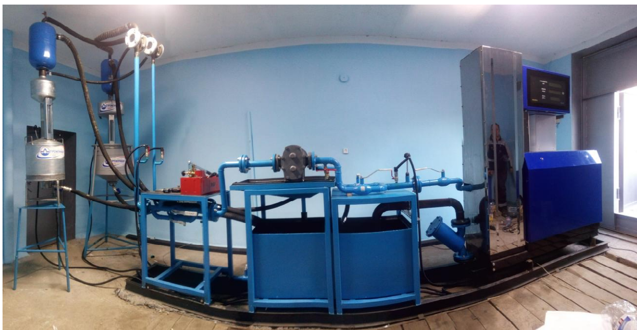
Рисунок 1 – Общий вид установок поверочных УПРЖ
