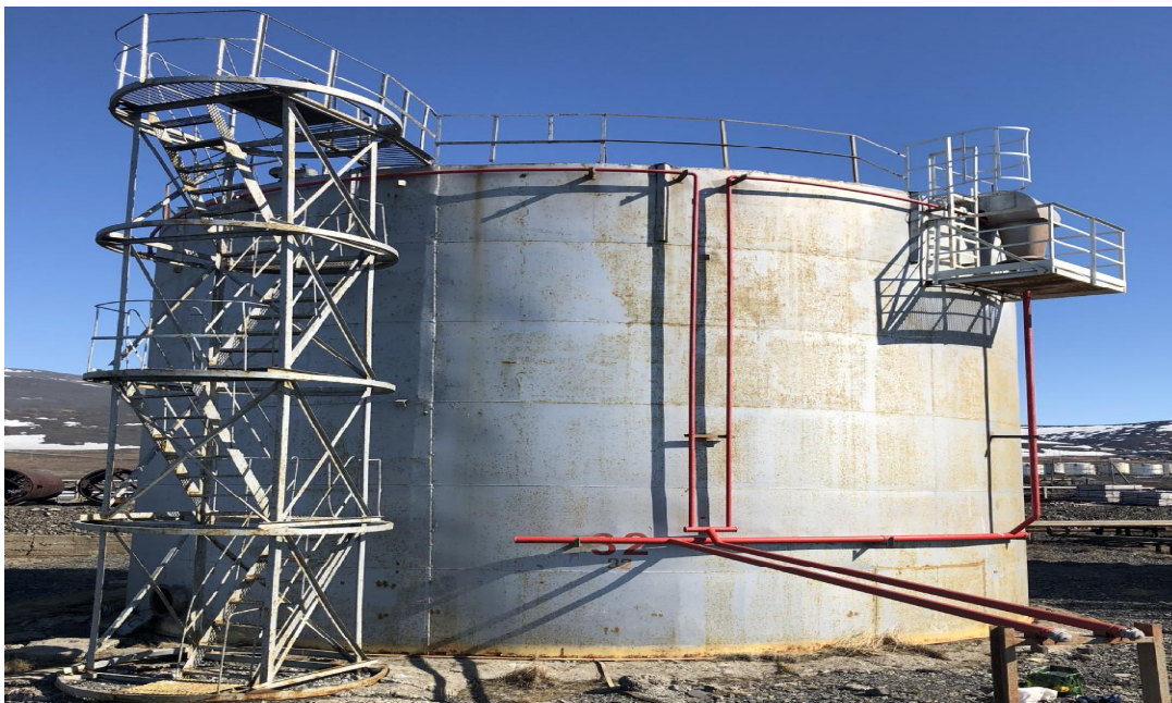
Рисунок 1 - Общий вид резервуара РВС-1000
