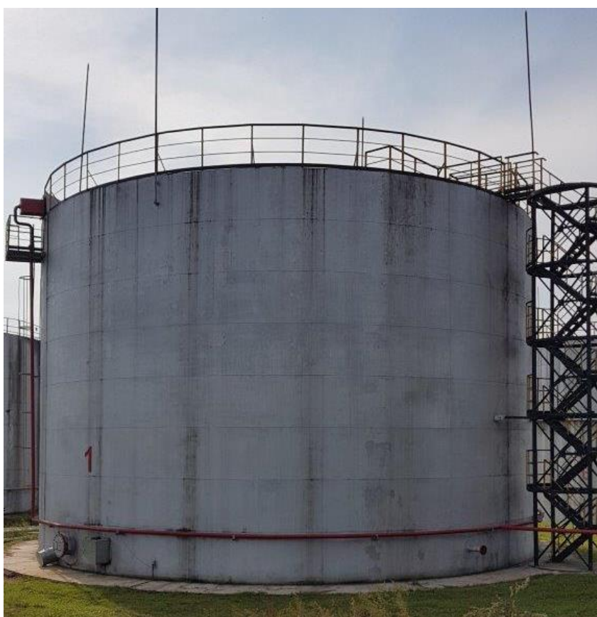
Рисунок 6 - Общий вид резервуара стального вертикального цилиндрического РВС-3000
