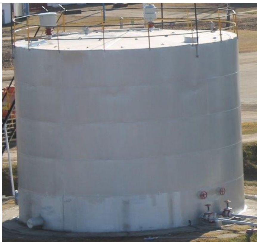
Рисунок 2 - Общий вид резервуара стального вертикального цилиндрического РВС-400
