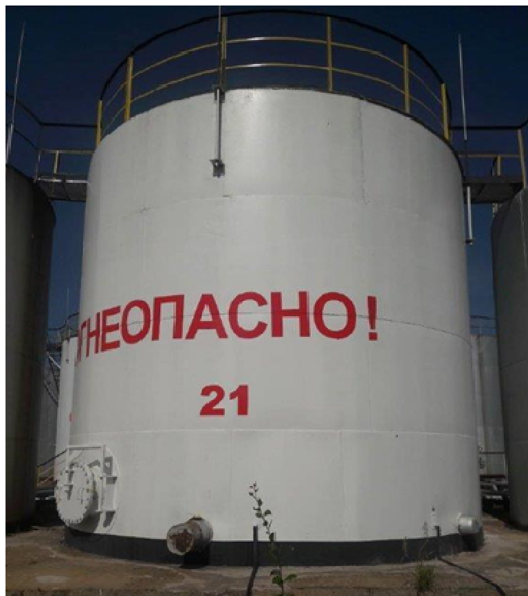
Рисунок 1 - Общий вид резервуара стального вертикального цилиндрического РВС-200
