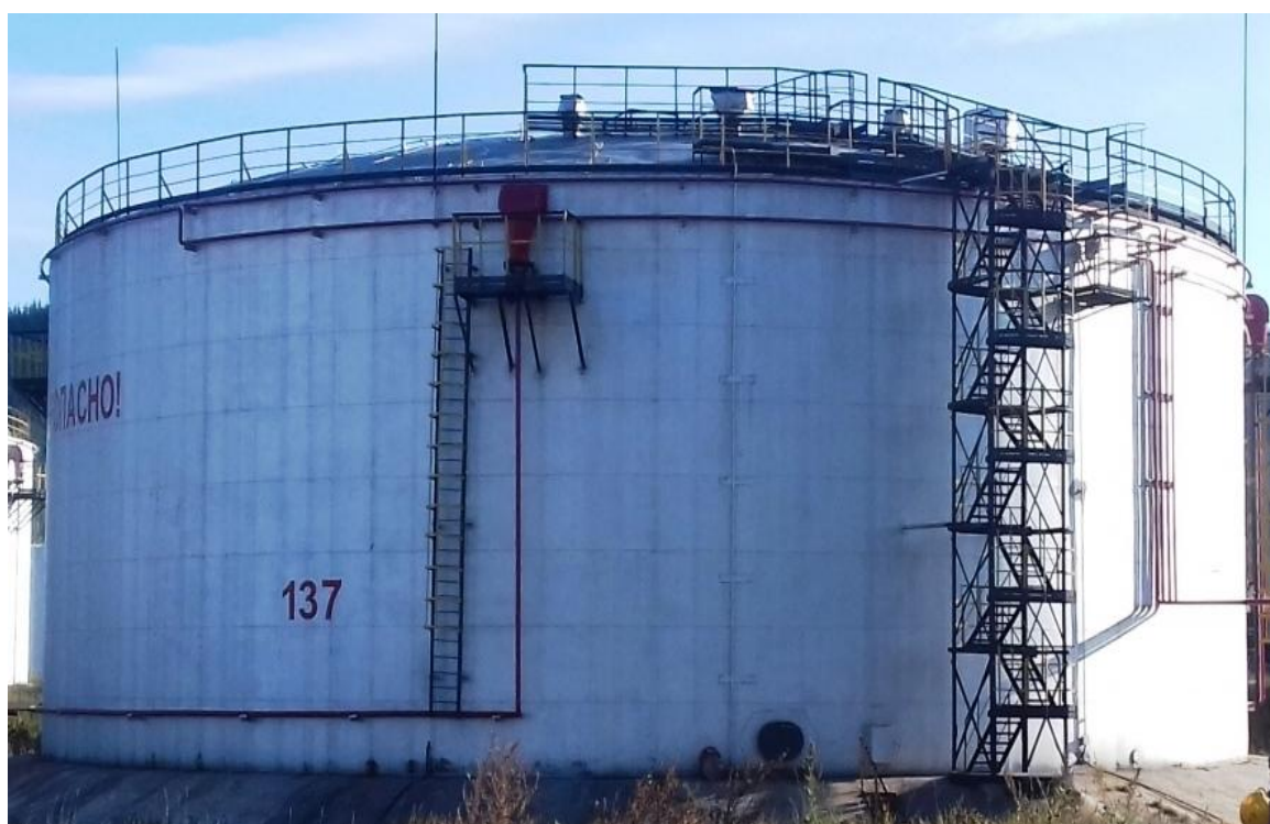
Рисунок 8 - Общий вид резервуара стального вертикального цилиндрического РВС-10000
